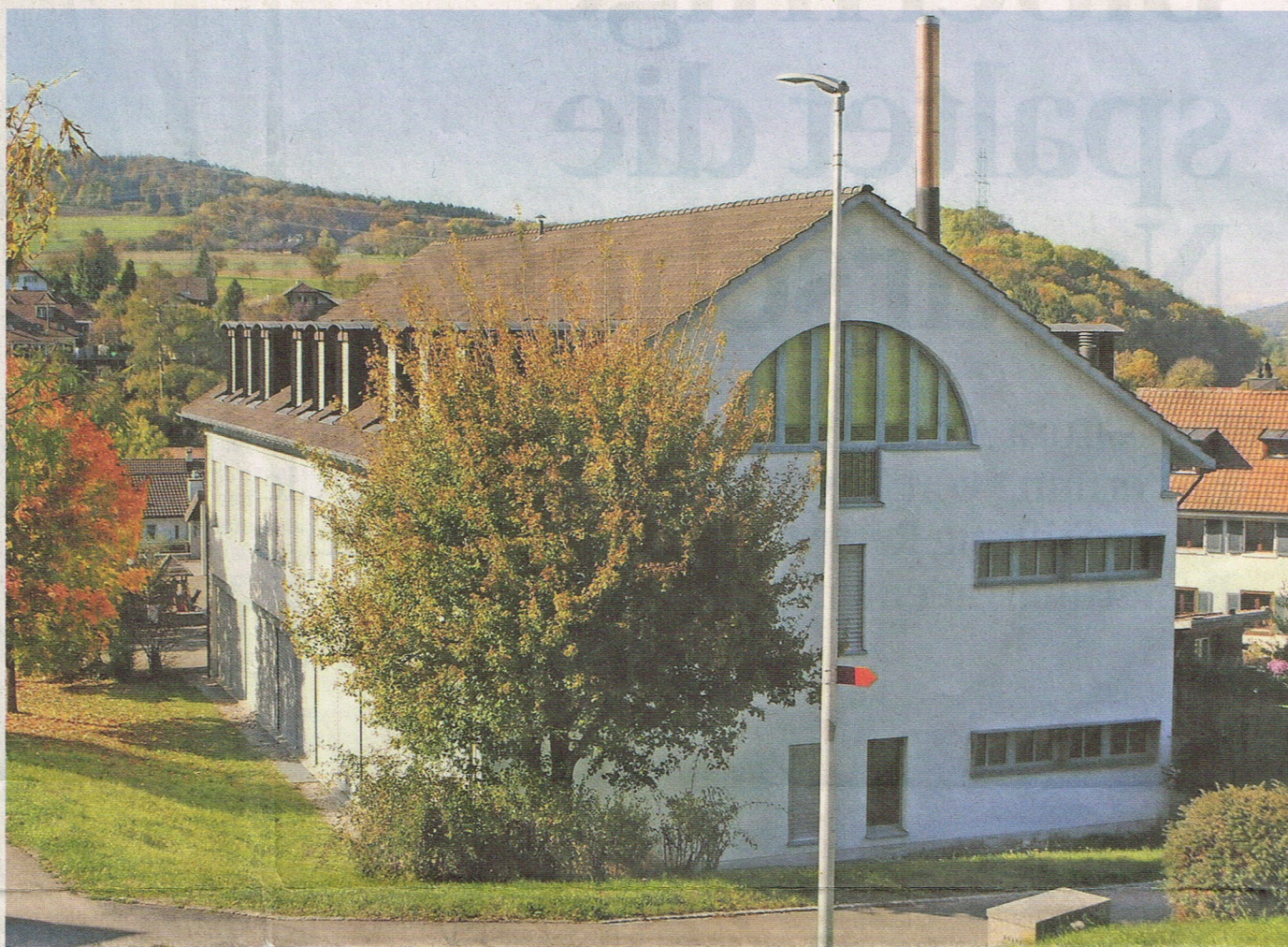
Im Schulhaus 1996 in Wegenstetten werden auch ab dem Schuljahr 2019/20 Oberstufenschüler ein und aus gehen.
